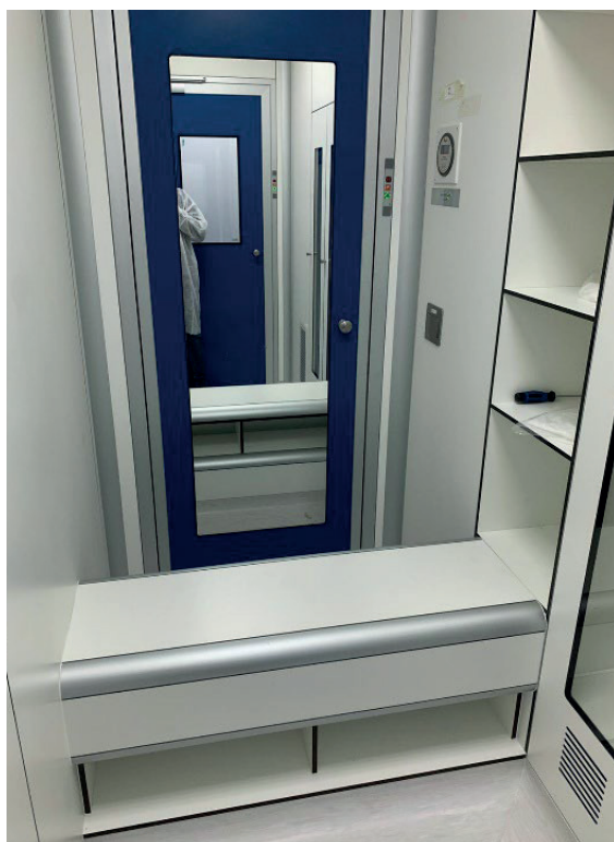
FOT. 3 Przykładowe wykonanie ławeczki przekroczonej w komorze próbkiowania
